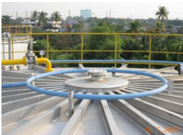
รูปที่ 2.2.1-6 ระบบท่อส่งน้ำหล่อเย็นบนถังเก็บ
