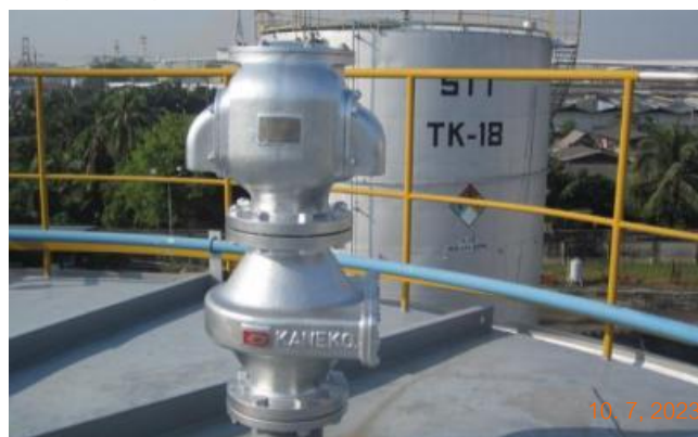
รูปที่ 2.2.1-1 Automatic Breather Valve
