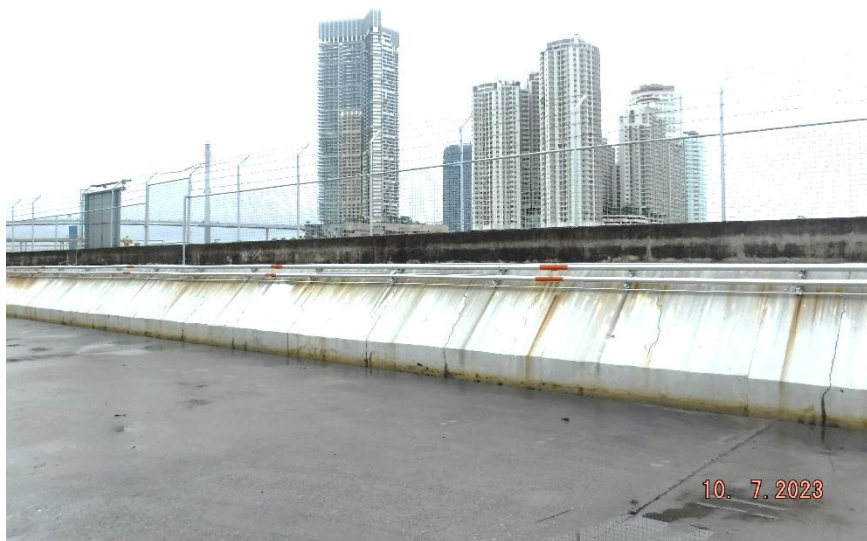
รูปที่ 2.2.2-1 กำแพงคอนกรีตเสริมเหล็กที่ล้อมรอบท่าเรือ
