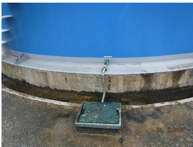
รูปที่ 2.2.1-7 สายดินของตัวถังถัง
