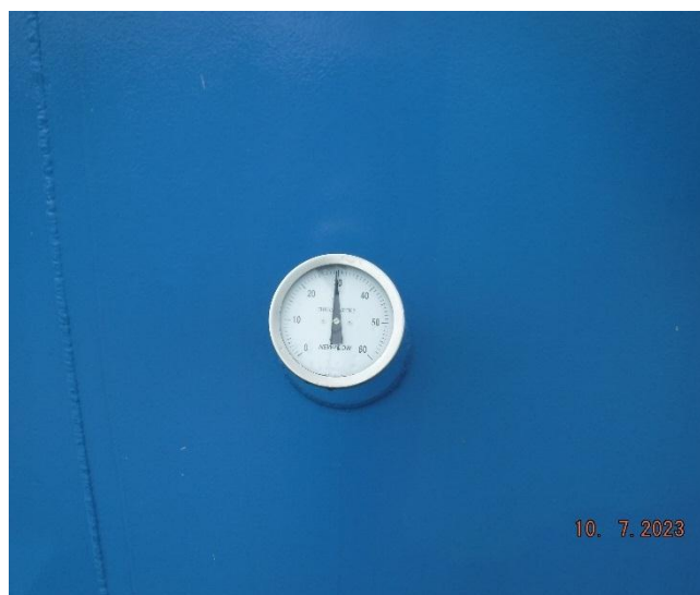
รูปที่ 2.2.1-3 เทอร์โมมิเตอร์ วัดอุณหภูมิสินค้าในแท้งค์
